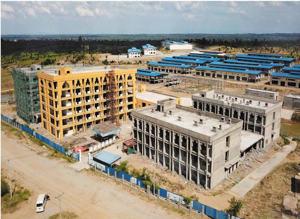
Mandalay-Myotha Baoshan Project တည်ဆောက်လျက်ရှိသည့် Standard Factories, Office Building, Canteen & Staff Dormitory
