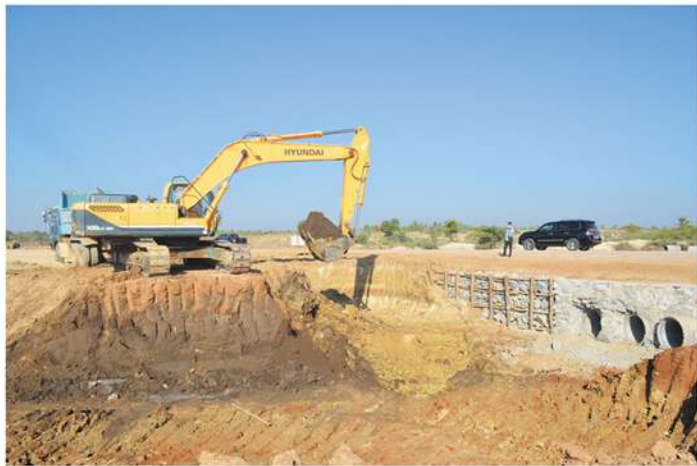
၂၀၂၀ ခုနှစ်တွင် တံတားဦးလေဆိပ် (စကားအင်းအိုင်) မှ ဗြူသာဝင်မူဥယျာဉ်သို့ 35km အရှည်ရှိ အိုင်အမာမြေသားလမ်း Box Culvert များ ထည့်သွင်း တည်ဆောက်နေစဉ်
