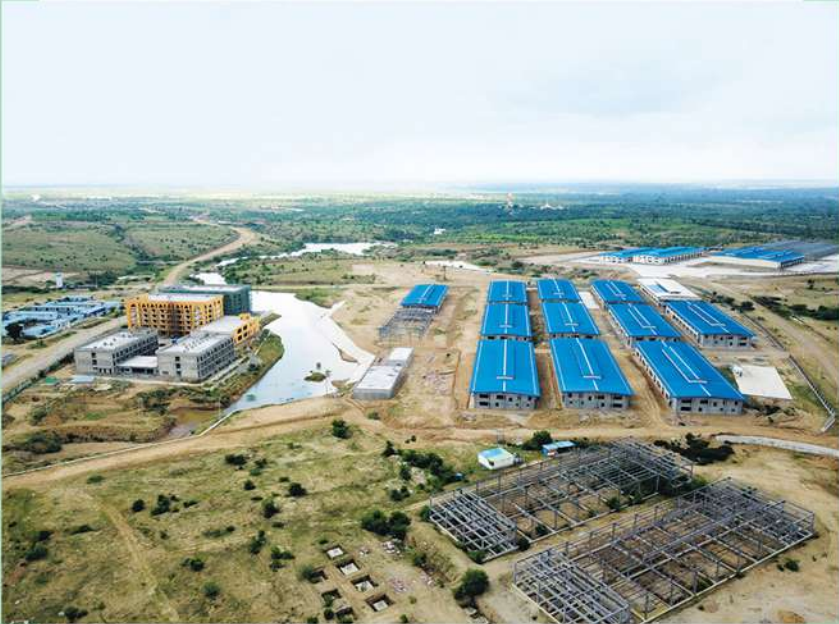
Mandalay-Myottha Baoshan Project တည်ဆောက်လျက်ရှိသည့် Standard Factories, Office, Canteen & Staff Housing
