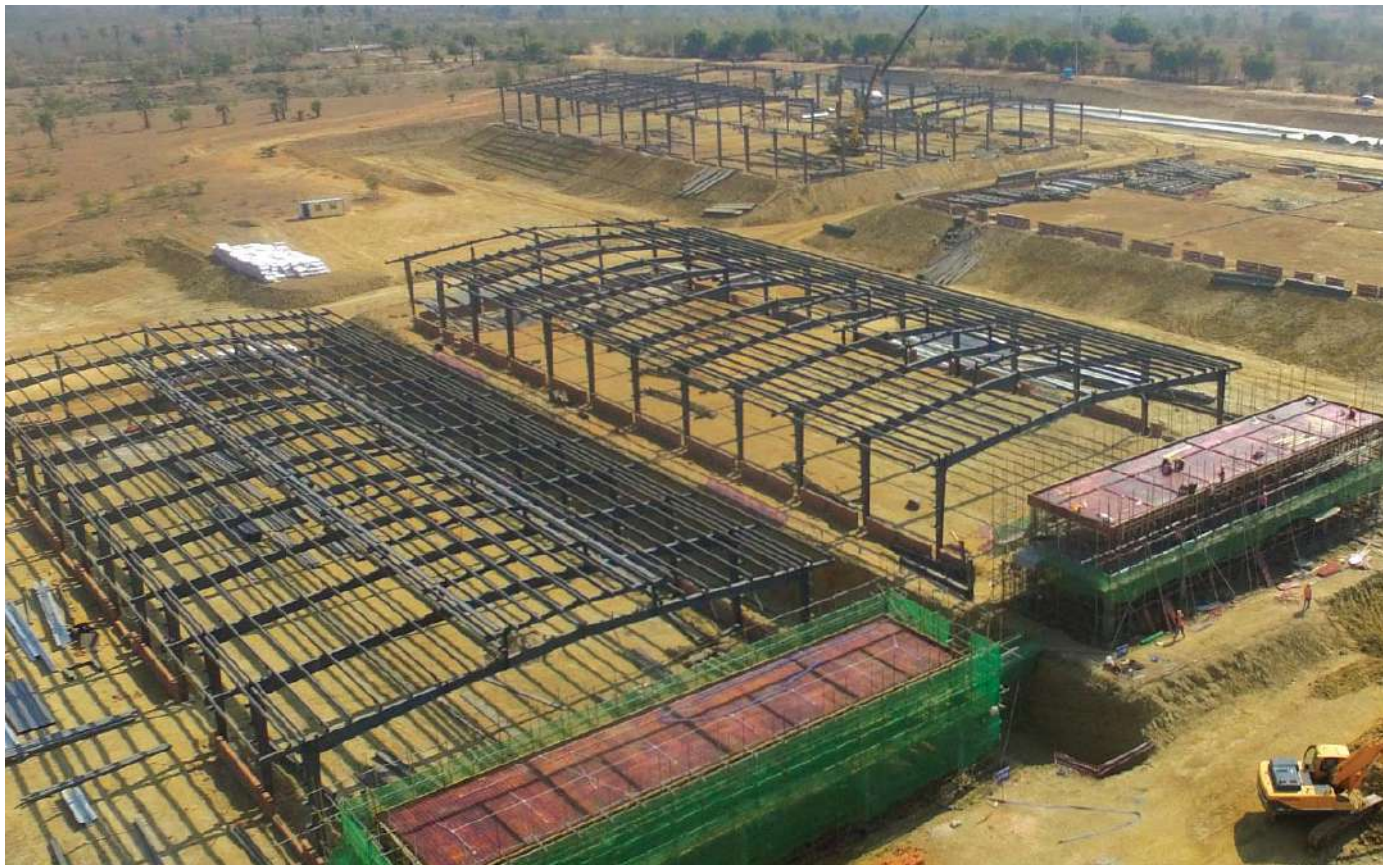
ပေါင်ရှန်းပြည်နယ်ခွဲ၏ လုပ်ငန်းရှင်အုပ်စုမှ Standard Factory & Warehouse များ စတင်တည်ဆောက်နေပုံ
