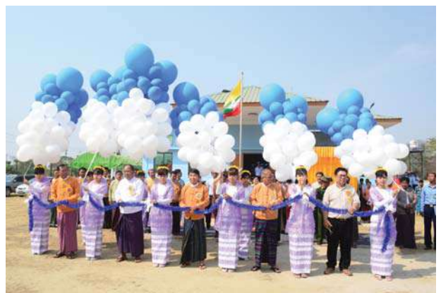
မြင်းခြံမြို့နယ် 66/11 KV, 5 MVA ကုက္ကဲခါတ်အားခွဲရုံ ဖွင့်ပွဲနှင့် ကုက္ကဲဒေသ မီးလင်းခြင်းအခမ်းအနားဖွင့်ပွဲတွင် လှုပ်စစ်၊ စွမ်းအင် နှင့် ဆောက်လုပ်ရေးဝန်ကြီးဦးဇော်အောင်နှင့် တာဝန်ရှိသူများက ဖဲကြိုးဖြတ်ဖွင့်လှစ်ပေးကြစဉ်
