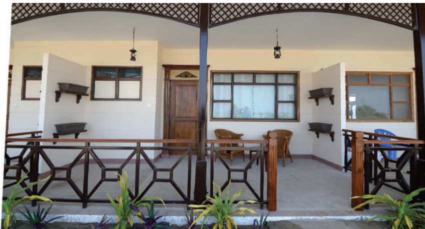
ဧည့်သည်များ တည်းခိုနိုင်ရန်အတွက် တည်းခိုဆောင်နှင့် အရာရှိရိပ်သာအဆောက်အဦများအား တွေ့မြင်ရသည့်မြင်ကွင်း
