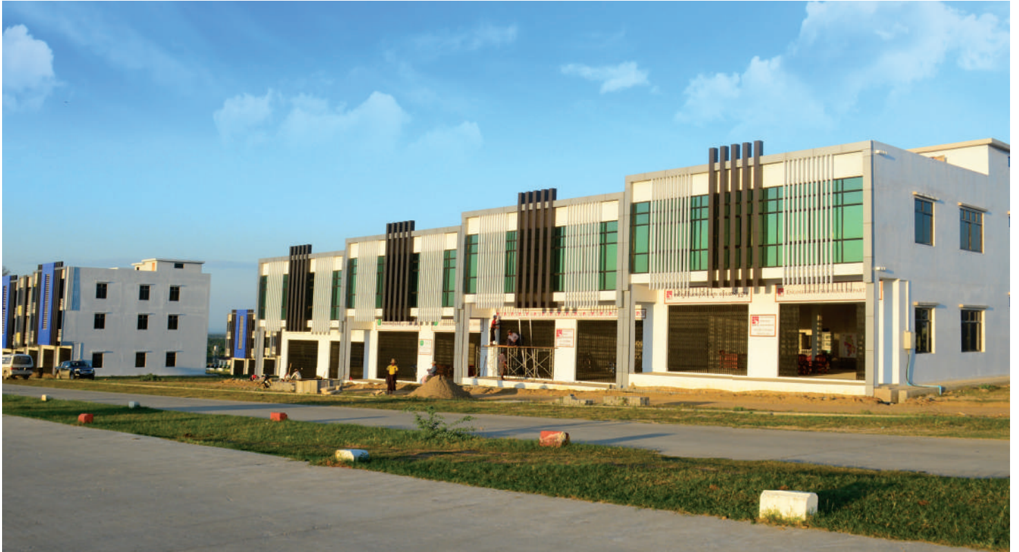
မြို့သာစက်မှုဥယျာဉ်မြို့တော်အတွင်း Shophouse များတည်ဆောက်ပြီးစီးမှု
