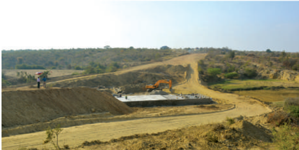
၂၀၁၈ ခုနှစ် မြို့သာစက်မှုဥယျာဉ်မြို့တော် စီမံကိန်းအတွင်းရေရရှိရေး၊ စိမ်းလန်းစိုပြေရေးအတွက်၊ လျှိုမြောင်း၊ ချိုင့်ဝှမ်းကြီးများအား စက်ယန္တရားကြီးများဖြင့် ရေစုကန်များအဖြစ်၊ တည်ဆောက်ကာ၊ ရေထုတ်ပြွန်များ တပ်ဆင်ခြင်း
