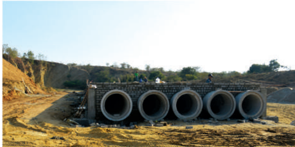
၂၀၁၈ ခုနှစ် မြို့သာစက်မှုဥယျာဉ်မြို့တော် စီမံကိန်းအတွင်းရေရရှိရေး၊ စိမ်းလန်းစိုပြေရေးအတွက်၊ လျှိုမြောင်း၊ ချိုင့်ဝှမ်းကြီးများအား စက်ယန္တရားကြီးများဖြင့် ရေစုကန်များအဖြစ်၊ တည်ဆောက်ကာ၊ ရေထုတ်ပြွန်များ တပ်ဆင်ခြင်း
