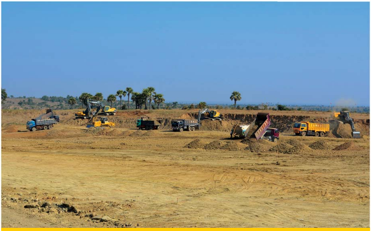
စက်မှုဥယျာဉ်တည်ဆောက်မည့် မူလပကတိ တည်ရှိခဲ့သော ကျောက်စရစ်ကုန်းများ၊ ကန္တာရပင်များနှင့် အောက်ခံကျောက်သားမြေများအား မြေပြင် ပြုပြင်မှုများအား တွေ့မြင်ရပုံ
