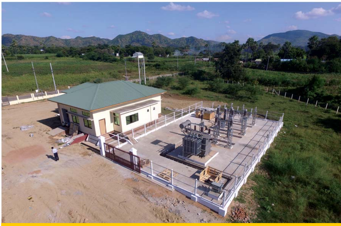
ကျေးရွာ ၅၈ ရွာ မီးလင်းရေးအတွက် ကုက္ကဲခွဲရုံ တည်ဆောက်နေမှုအား တွေ့မြင်ရပုံ
