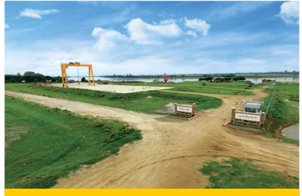
ဆိပ်ကမ်း ပင်မဝိတ် RMG Crane အား တွေ့မြင်ရပုံ
